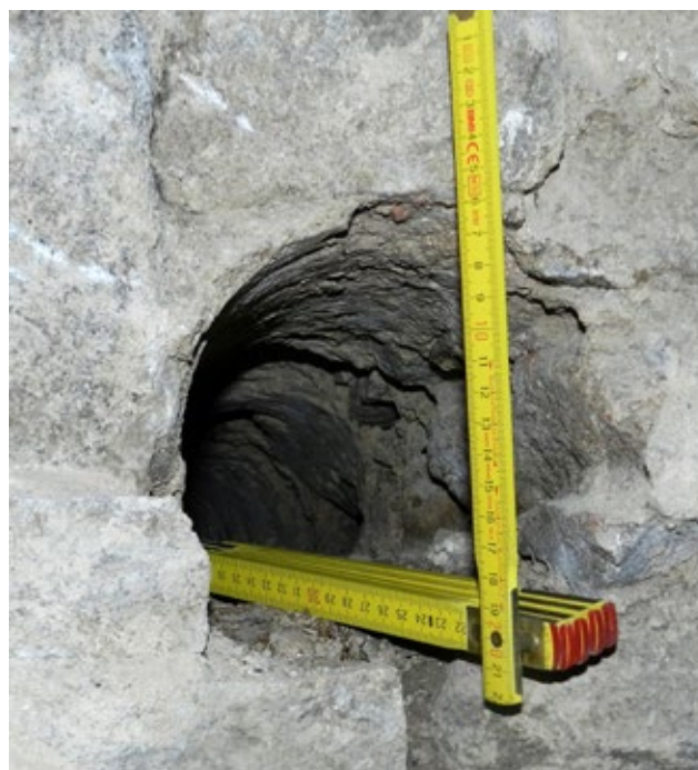
Obr. 3: Otvor pro dřevěné lešení v hradbě, foto D. Zimola.
