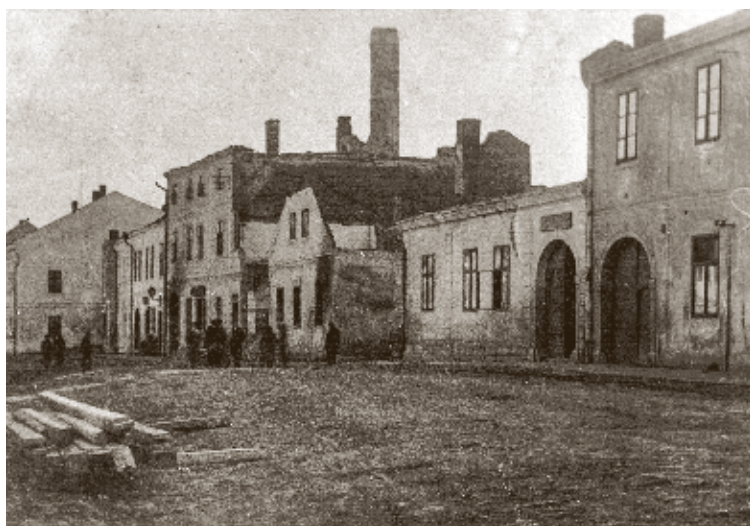
Ulice Nádražní po požáru
