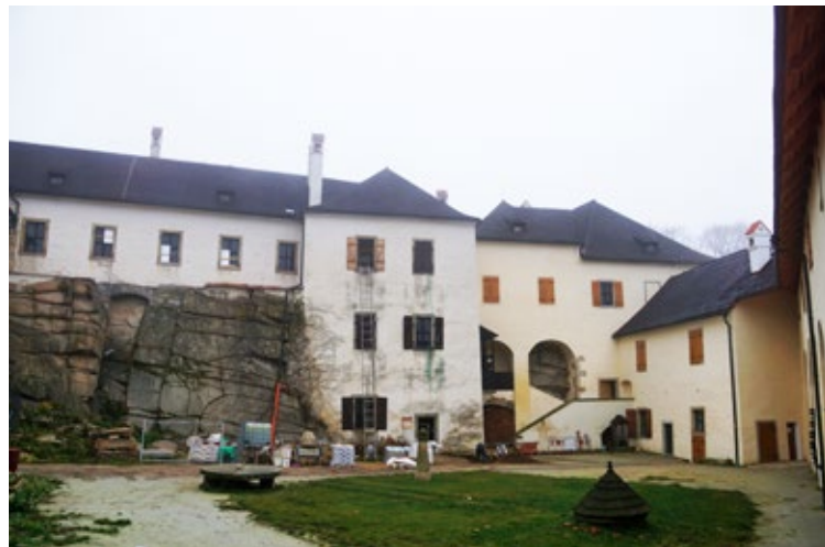
Obr. 1: Nádvoří hradu v době rekonstrukce, foto D. Zimola.
